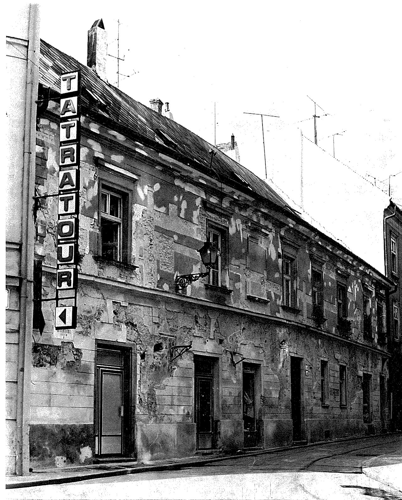
Priečelie domu č. 6 na Wolkrovej ulici, stav počas prieskumu. Foto M. Smoláková
