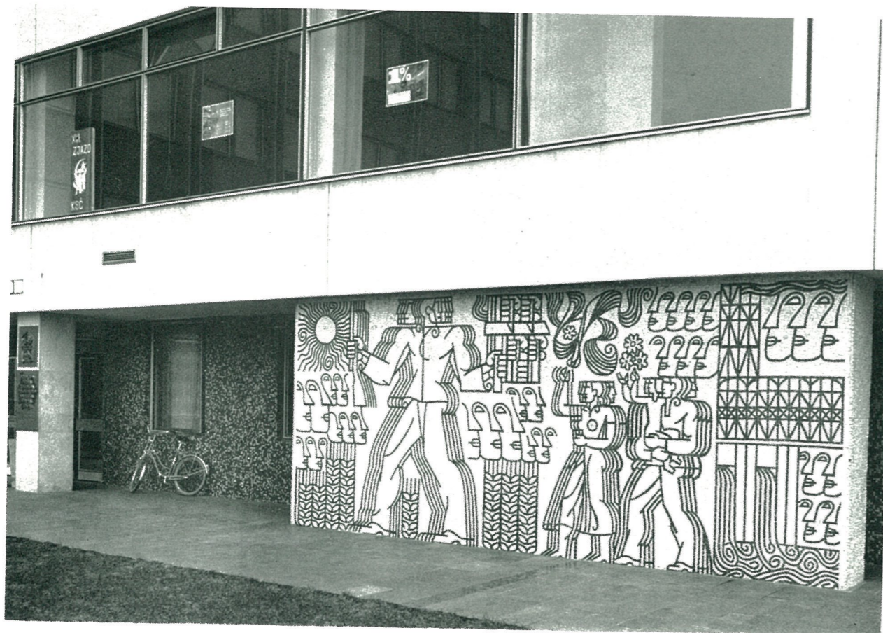
3. Rudolf Moško, kamenná mozaika na fasáde objektu justičných orgánov, Trenčín, 1978
