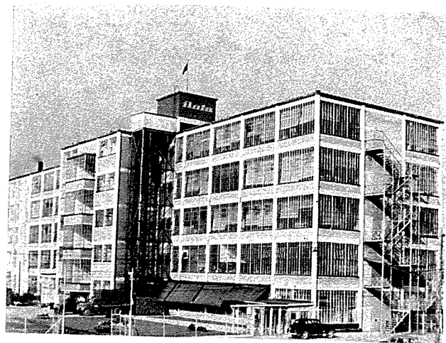
Projektové oddelenie SAS Zlín: Výrobná budova v Batawe, Ontario, Kanada, 1939. Z archívu J. Novotného
