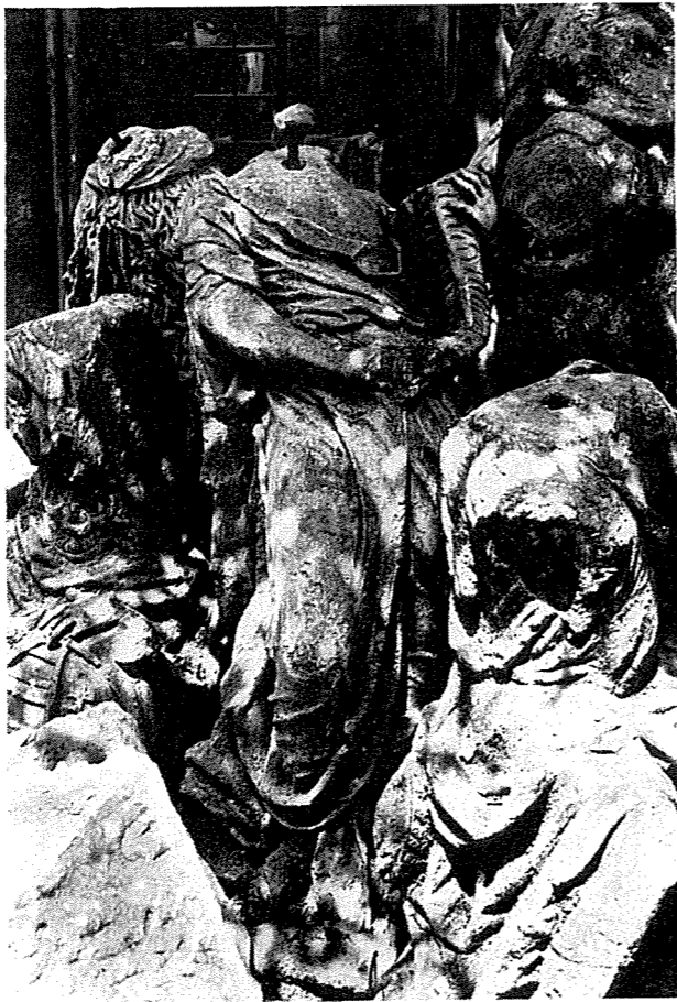
Sochy z pomníka Jána Nepomuckého po demontáži. Foto ŠÚPS
