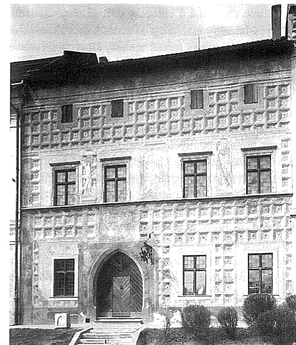
Priečelie Krupekovej domu (č. 44) na Hlavnom námestí v Levoči, 16. stor. Foto J. Sedlák
