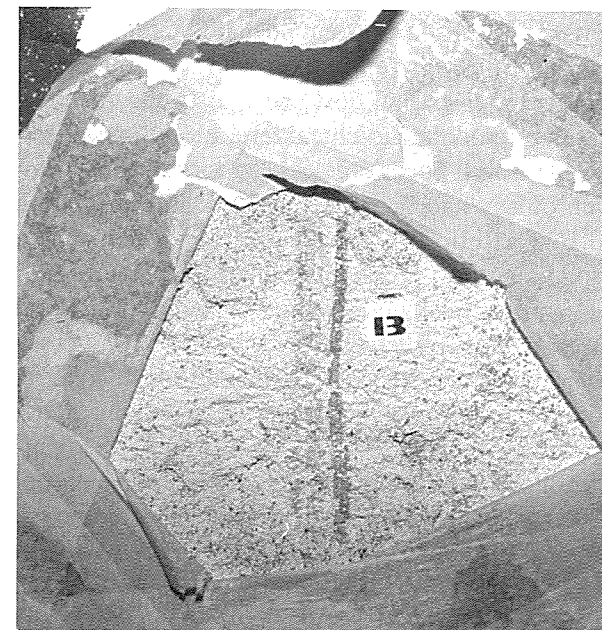
47 b. Detail - odpadnuté vrstvy maľby v spodnej časti Kadmovej kopije (odkryté arriccio s viditeľnou sinopiou)
