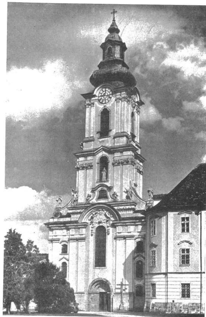
13. Turmfassade des Stiftes Wilhering
