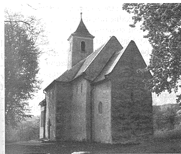
8. Pohľad na exteriér kostola sv. Juraja v Kostolnoch
