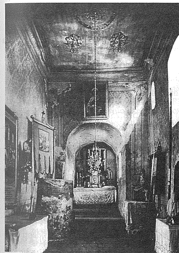
9. Pohľad do interiéru kostola sv. Juraja pred rekonštrukciou
