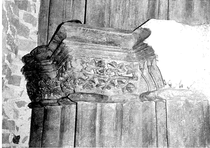
9. Západný gotický portál kostola, severné ostenie
