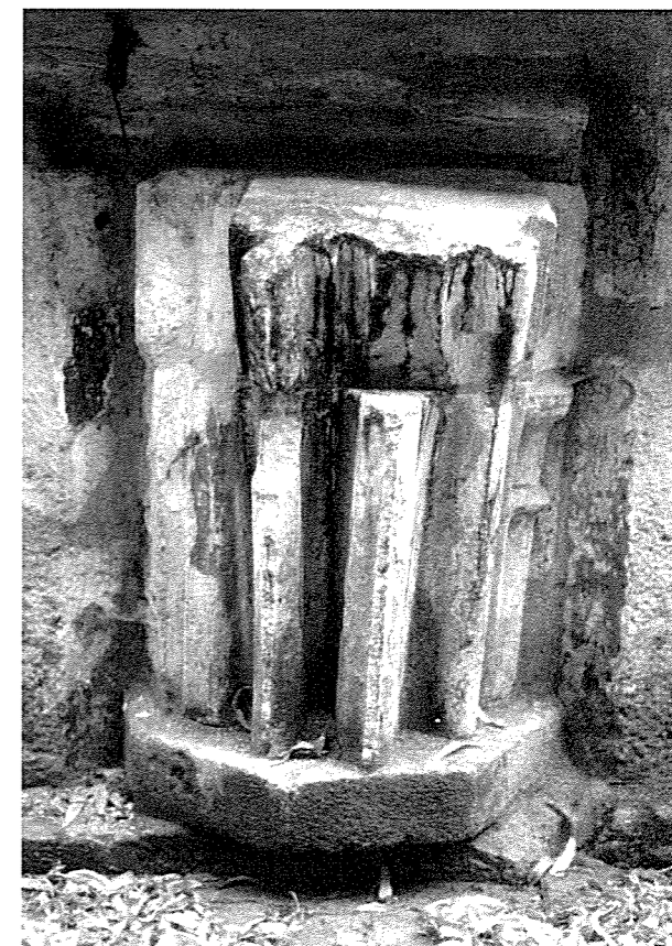
8. Fragment z kamenej gotickej klenby lode kostola – krycia doska hlavice s nábehom rebier
