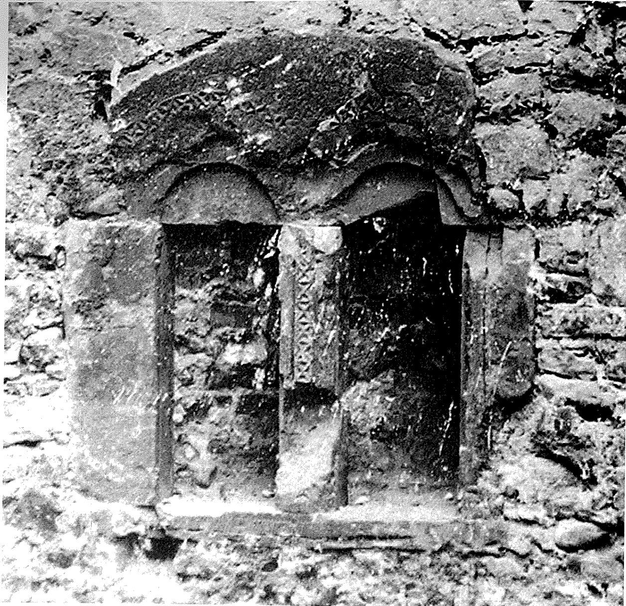
12. Doppelfenster (Ende 12. Jahrhundert) aus der Seitenfassade eines Steinhauses. 1910 entdeckt, dokumentiert und abgerissen (Freiburg, Franziskanerstraße 3/5). Foto: Landesdenkmalamt Baden-Württemberg, Außenstelle Freiburg.
