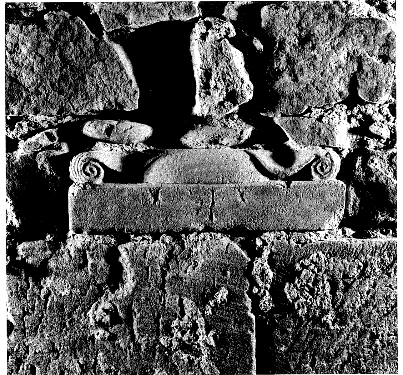
3. Basis einer Fenstersäule, 13. Jahrhundert, später als Baumaterial wieder verwendet (Freiburg, Salzstraße 20). Foto: Landesdenkmalamt Baden-Württemberg, Außenstelle Freiburg.
