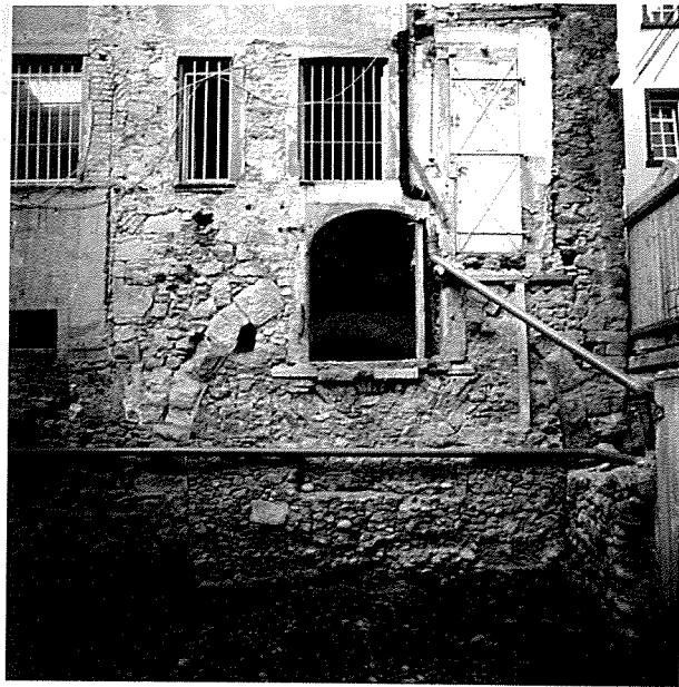
7. Ehemaliger rundbogiger Kellerzugang, später vermauert und durch eine höher sitzende Tür ersetzt (Freiburg, Salzstraße 20). Foto: Landesdenkmalamt Baden-Württemberg, Außenstelle Freiburg.
