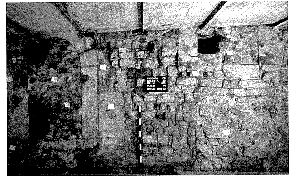
13. Hausecke mit vorspringendem Sockel (um 1127), seitlich angesetzter Tür (links) und nach Straßenaufschüttung 1170/80 höher eingebrochene Tür (rechts). Foto: Landesdenkmalamt Baden-Württemberg, Außenstelle Freiburg.
