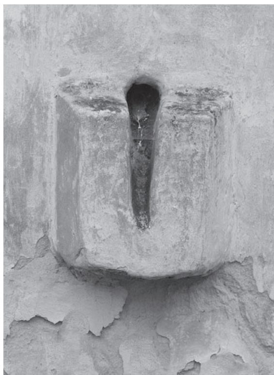
Obr. 19: Poniky, Kostol sv. Jána Evanjelistu (dnes Františka Serafínskeho), sakristia, detail exteriérového vyústenia lavaba. Foto B. Pomfjová.
