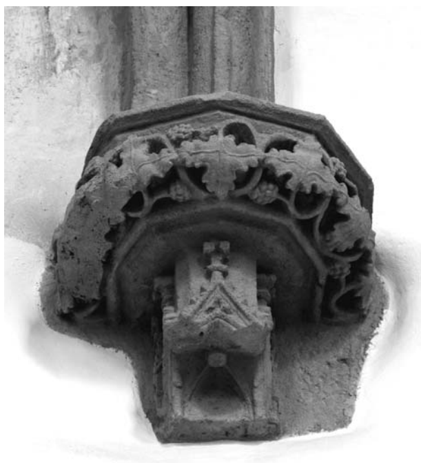
Obr. 18: Bratislava, kostol klarisiek, klenbová konzola v lodi. Foto: P. Breier, archív Centra ved o umení SAV – Ústavu dejín umenia.
