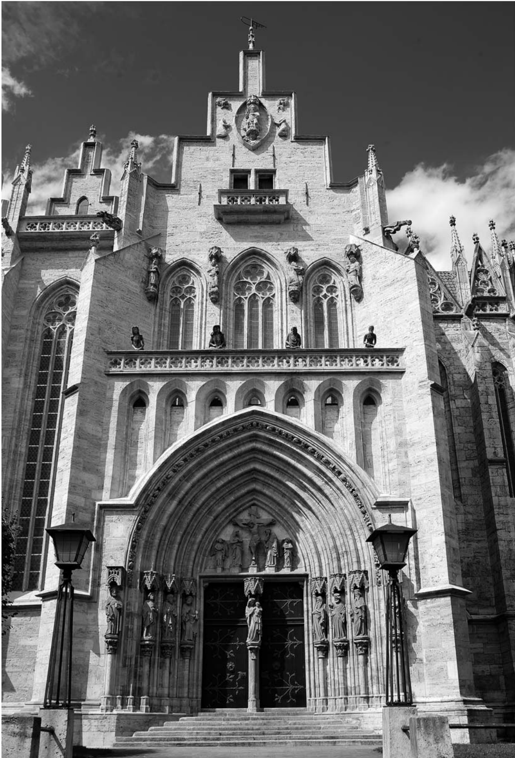
Abb. 14: Mühlhausen, Marienkirche, Südfassade des Querhauses. Photo: J. Adamski.
